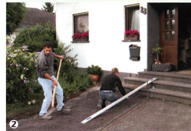
Bild 2: Der weitgehend intakte Unterbau erspart die Kosten für Erdarbeiten. Die alten Steine wurden entfernt und das vorhandene Pflasterbett korrigiert. Danach konnte sofort das neue Pflaster verlegt werden.
